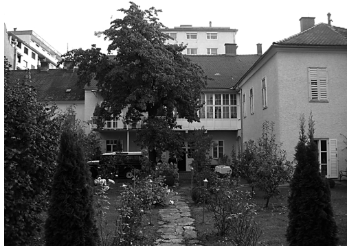
Sl. 14. Dvorište zgrade u Merangasse 24
